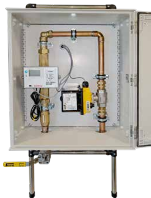
Ill.: Sektion med måler og ventil
